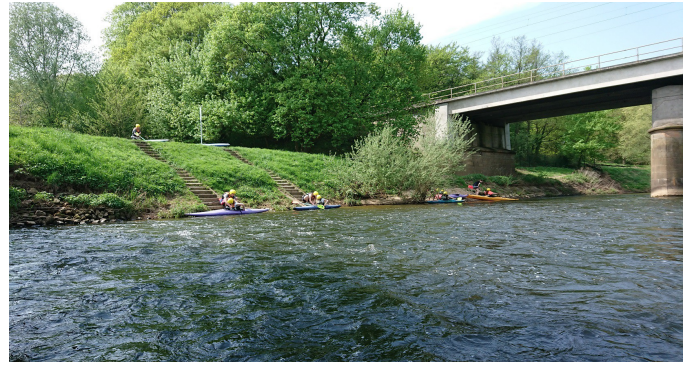
Ems km 16,0 Eisenbahnbrücke
