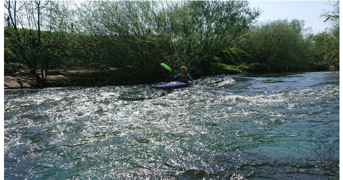
Ems km 22,7 Sohlschwelle
