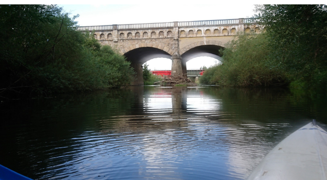
Ems km 10,2 Kanalüberführung („KÜ“)
